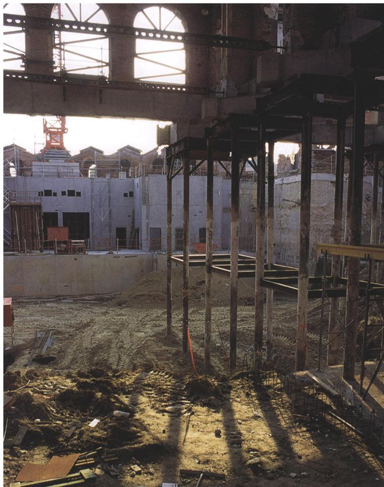
Etaieement de la maçonnerie du bâtiment pendant la phase d'excavation
